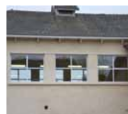
Nouvelles fenêtres du Foyer Rural
