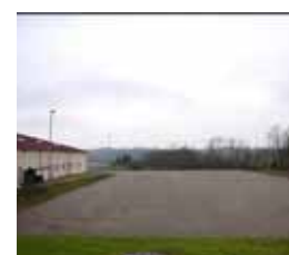
Terrain multisport en cours de réalisation
